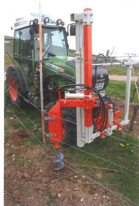
Abb. 8: Hydraulischer Erdbohrer am Hubmast eines Pfahldrückers
